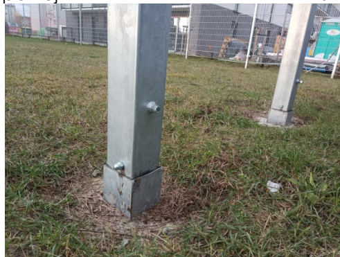
Fot. 2 Kosz do koszykówki – sposób posadowienia
